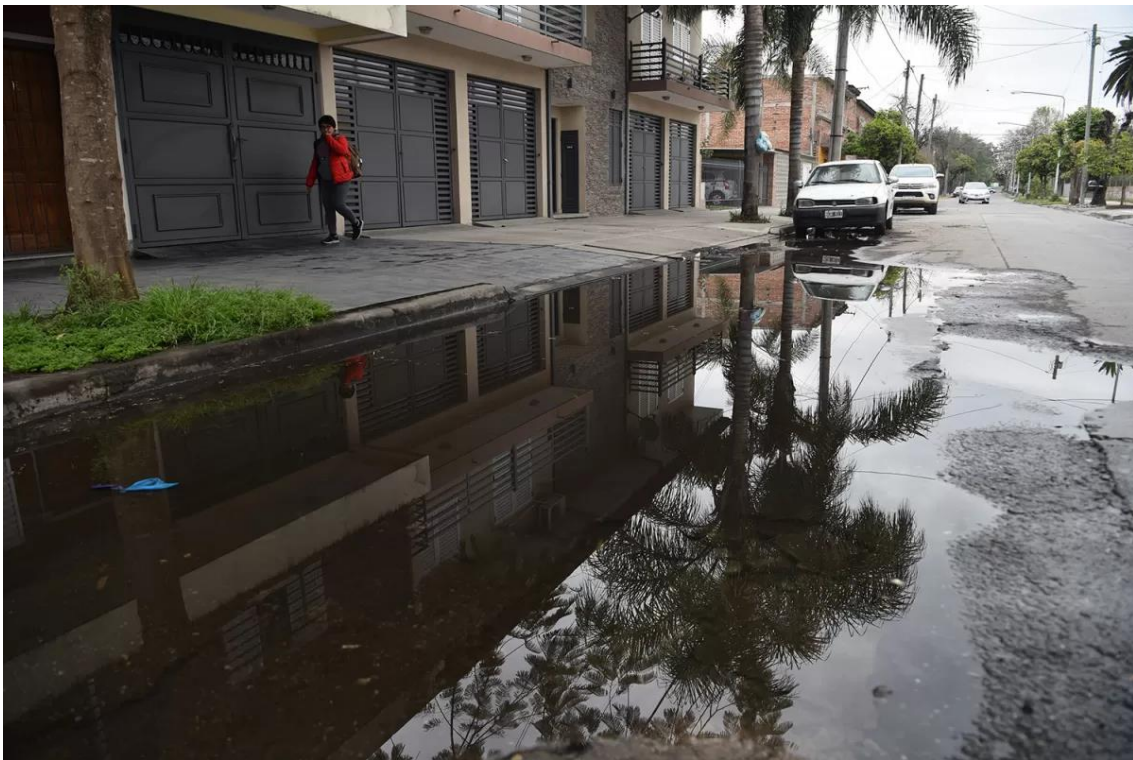
Afloramiento de líquidos cloacales en la vía pública
