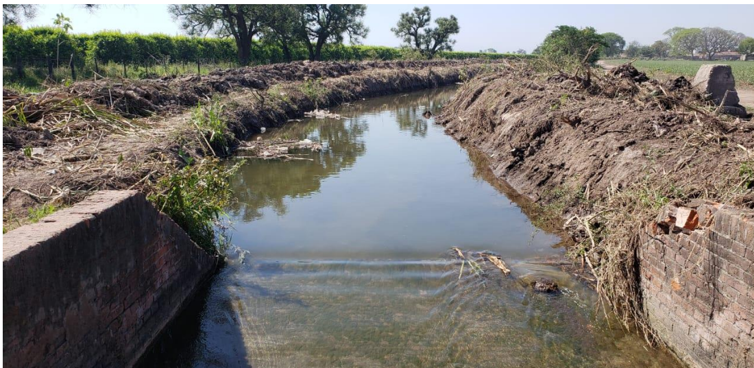
Canal de riego sin revestimiento.
